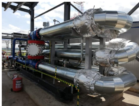
Рисунок 1 – Общий вид установок трубопоршневых «НАФТА-ПРУВЕР»-300
